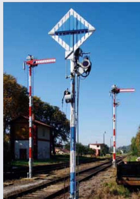
Seřadovací návěstidlo Se 1. V pozadí odjezdová návěstidla a vodárna
