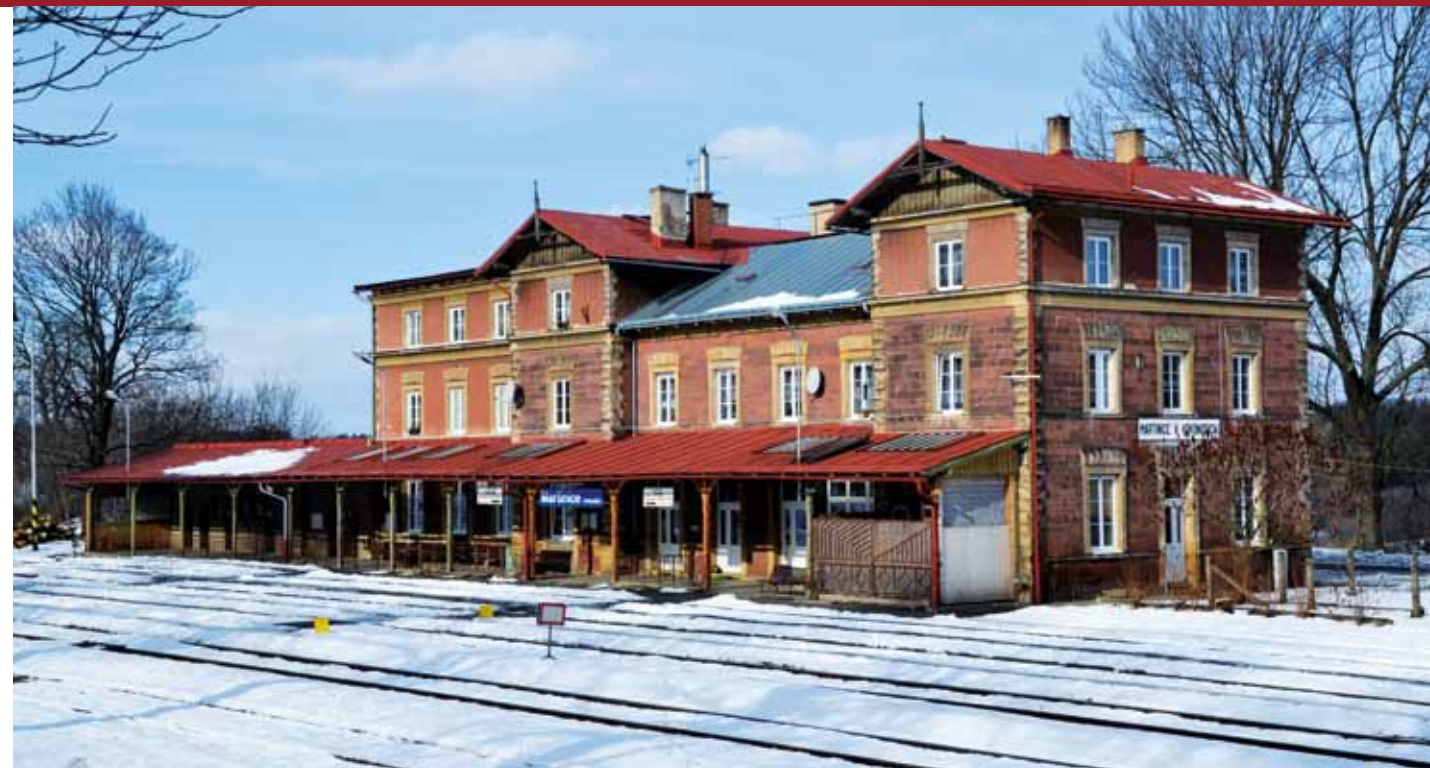
Pohled na výpravní budovu od kolejiště, vlevo přístavba pro místní dráhu do Rokytnice nad Jizerou
