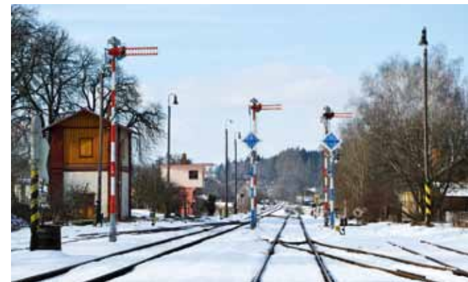
Pohled na roztocké/jilemnické zhlaví stanice. Vlevo vodní jeřáb a vodárna, v pozadí stavědlová věž St. 2
